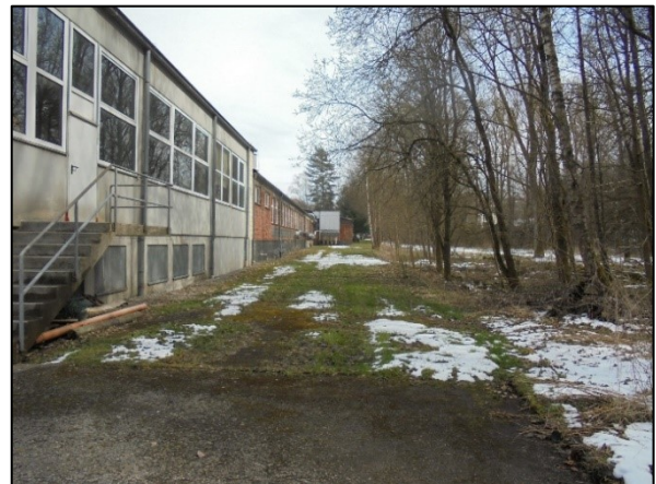
Abb. 7: Blick auf das südliche Plangebiet aus Westen. Die Bäume stehen außerhalb des Vorhabenbereichs.
