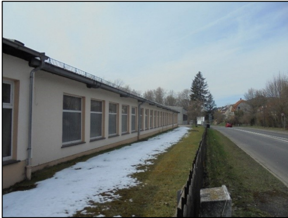
Abb. 4: Blick auf das nördliche Plangebiet aus Osten.
