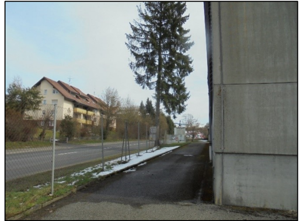
Abb. 5: Blick auf das nördliche Plangebiet aus Westen.
