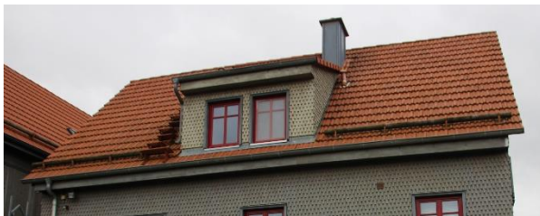
Abb. 37: Schleppgaube, die sich in das Dach einordnet
