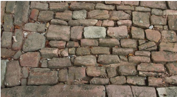
Abb. 54: historisches Natursteinpflaster aus Granit (oben) und Buntsandstein (unten)
