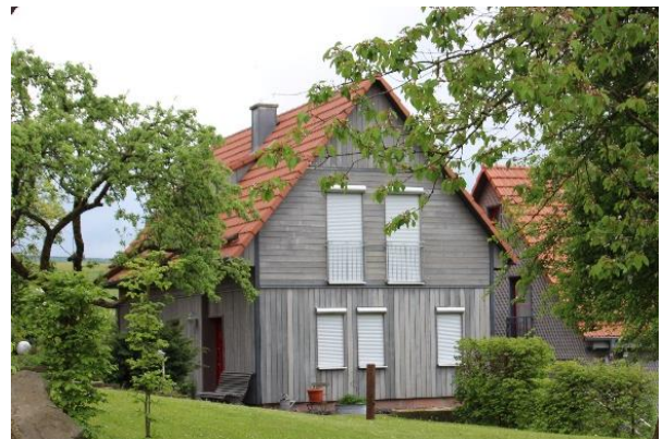
Abb. 33: Beispiel für einen in seiner Gebäudekubatur gelungenen Anbau in Sandberg
