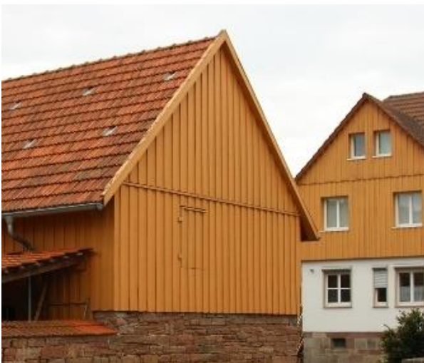
Abb. 42: neue Brettschalung in Anlehnung an historisches Vorbild
