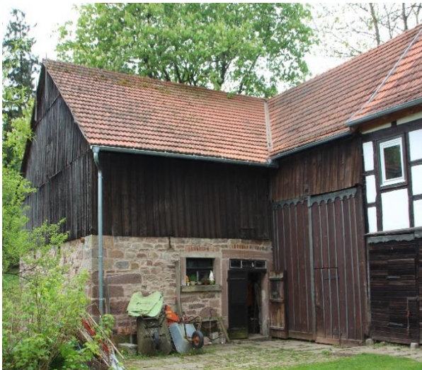
Abb. 30: noch vollständig erhaltener Hakenhof in Maiersbach
