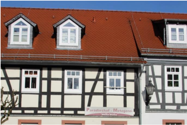
Abb. 39: Sichtfachwerk in der Gersfelder Innenstadt
