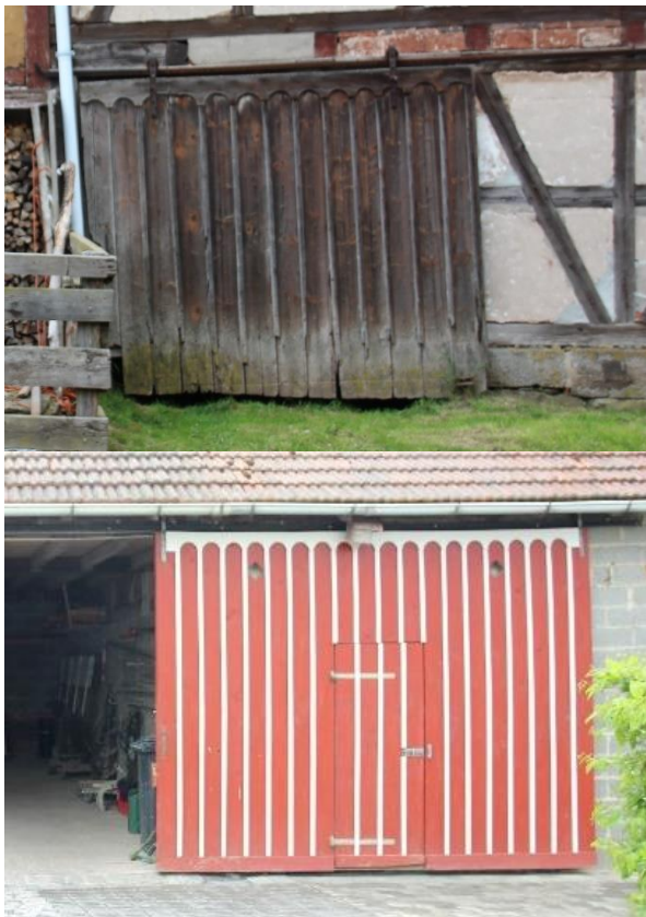
Abb. 48: altes und neu gebautes traditionelles Rolltor mit Aufdopplungen und dem typischen oberen Abschluss in Form einer Bogenreihe
