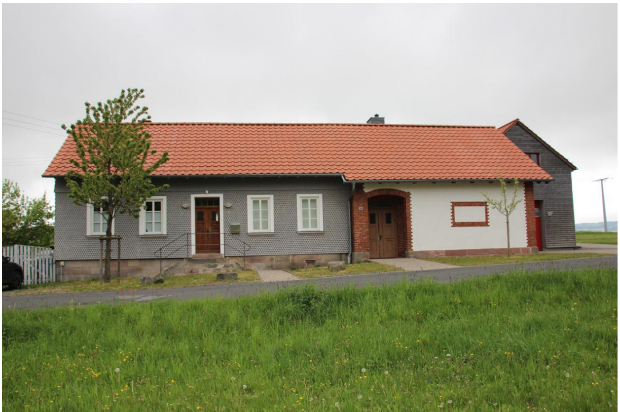
Abb. 16: Die ehemalige Schule von Rodenbach steht unter Denkmalschutz und wird heute als Dorfgemeinschaftshaus genutzt.
