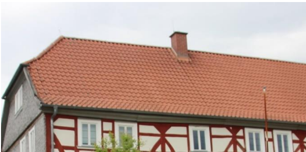
Abb. 35: Satteldach mit Krüppelwalm
