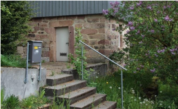
Abb. 52: neue Treppe mit Betonblockstufen und einfachem Geländer, die sich an der traditionell schlichten Gestaltung orientiert
