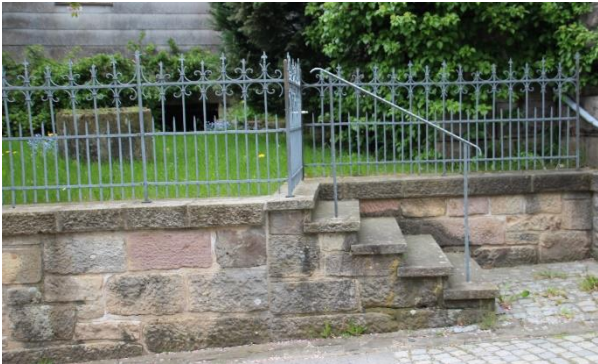
Abb. 51: kleine Außentreppe mit Plattenstufen
