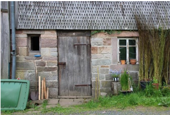
Abb. 41: Erdgeschosszone in Buntsandstein
